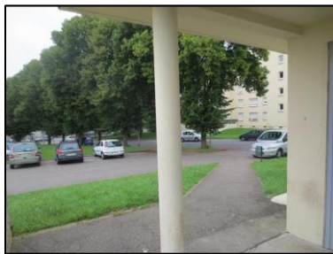
Photo N° 1090 AMIANTE CIMENT - -HALL EXTERIEUR Poteaux Coffrage perdu
